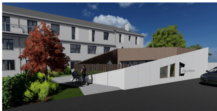
Vue entrée rue du Bon Repos
